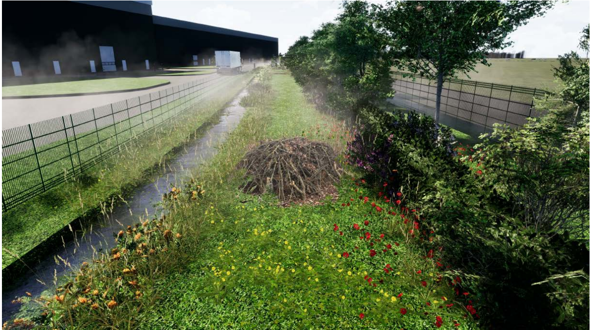
Corridor écologique – Vue proche de la cellule 14
